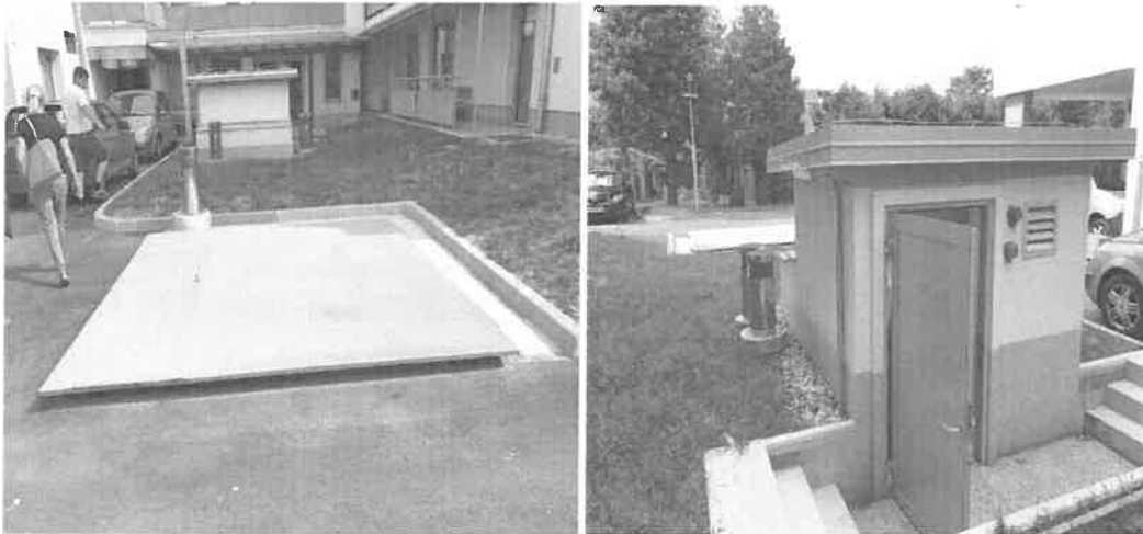
Slika 6: Kotlovnica Dom upokojencev Tolmin
