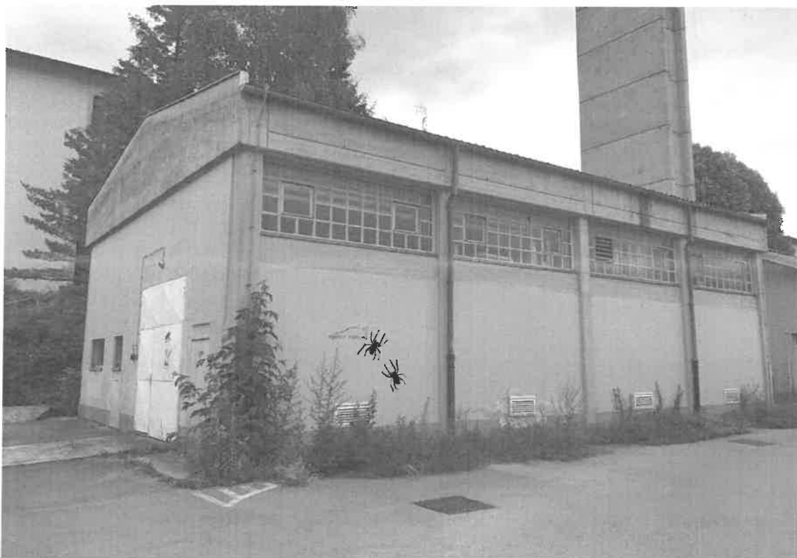
Slika 3: Objekt (območje stare vojašnice), kjer je predvidena kotlovnica
